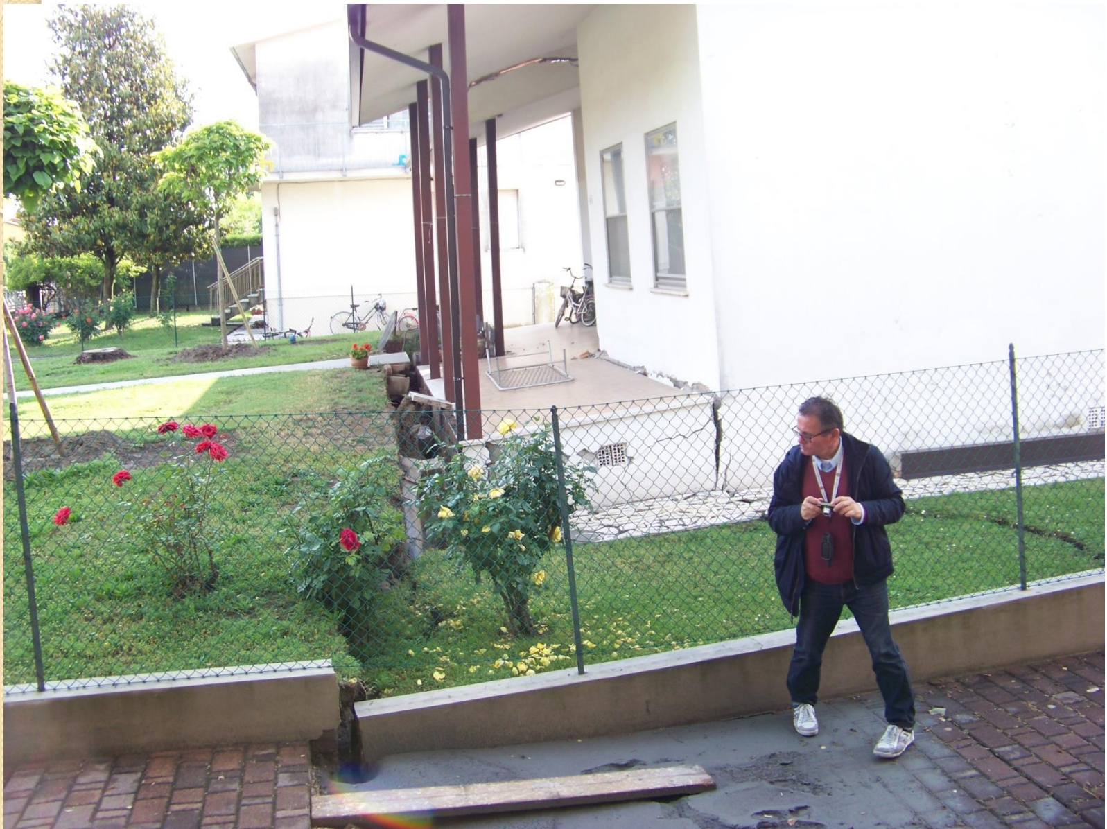
Frazione San Carlo; fenomeno di sprofondamento associato a fratturazione e liquefazione delle sabbie
